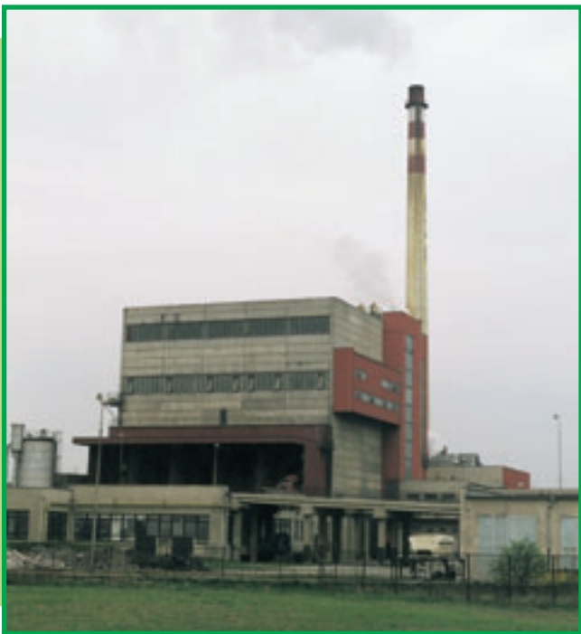
Spaľovňa odpadov v Košiciach produkuje 70 - 330 násobne vyššie emisie dioxínov ako je limit odporúčaný EU jedným zo zdrojov chlóru a následne aj dioxínov v nej je aj PVC. Foto: Spoločnosť priateľov Zeme
